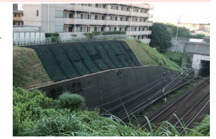
対策済の法面
